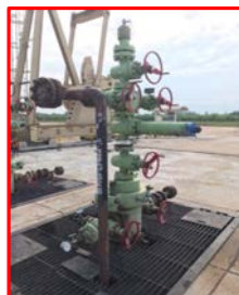
วาล์วฉุกเฉินระดับพื้นผิว (Shutdown valve)
